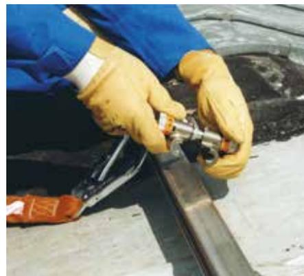
Le coulisseau ouvrant peut s'insérer ou s'enlever en tout point de l'installation. L'ouverture ou la fermeture se fait en tournant la bague moletée.
