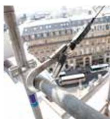
Mousquetons à grande ouverture permettant de connecter l'enrouleur à rappel automatique sur des points d'ancrage importants
